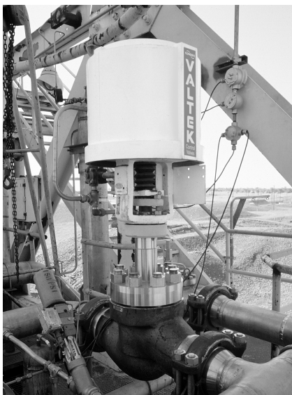
Этот клапан Mark One в низкотемпературном исполнении установлен в качестве дренажного клапана на линии подачи кислорода в оборудовании для изучения воздушно-космического пространства
