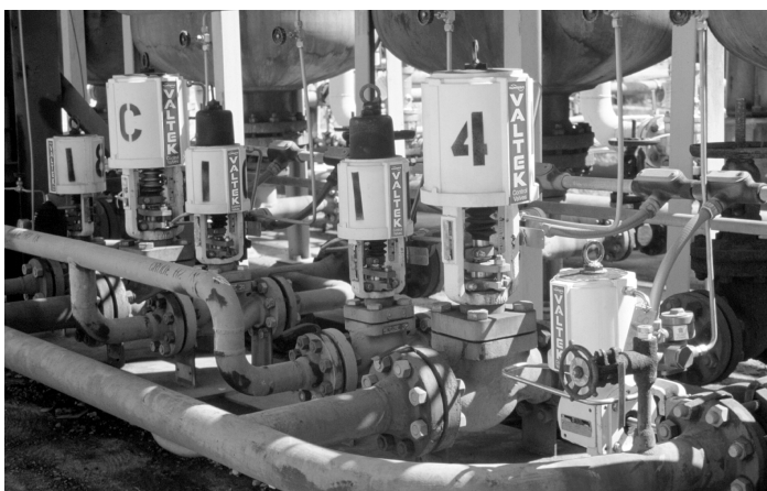
Этот клапан Mark One в низкотемпературном исполнении установлен в качестве дренажного клапана на линии подачи кислорода в оборудовании для изучения воздушно-космического пространства
