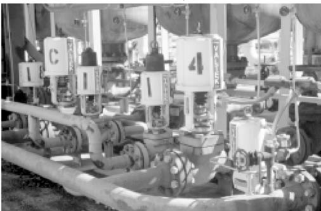
Mark One-Tieftemperaturventil als O 2 -Belüftungsventil in einem luftfahrttechnischen Prüfsystem .
