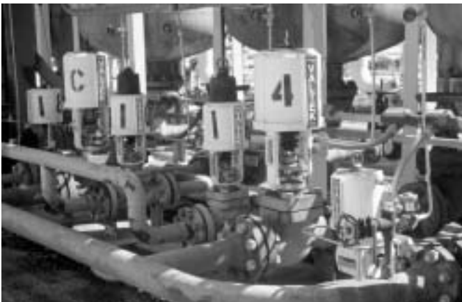
(gauche) Série de vannes utilisées pour commander un PSA.
