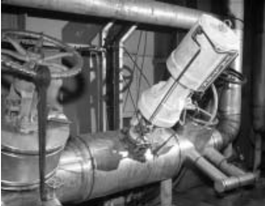
Une Mark One de 4" avec volant latéral installée dans un réseau d'eau alimentaire de chaudières.
