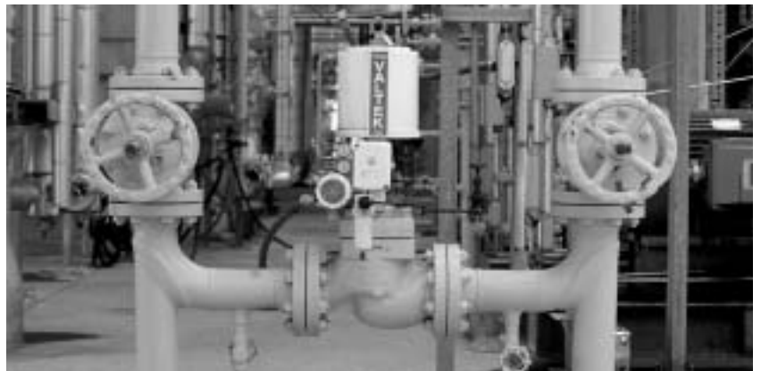
Vannes de contrôle huit pouces fonctionnant dans une usine d'hydrocarbure liquide avec une pression aval de 40 bar.
