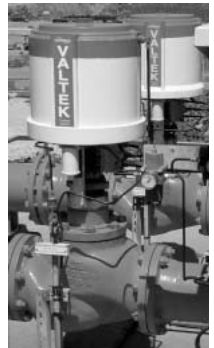
Vannes de contrôle huit pouces fonctionnant dans une usine d'hydrocarbure liquide avec une pression aval de 40 bar.
